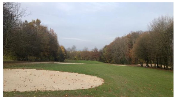
Bahn 14 mit sanierten Bunkern
