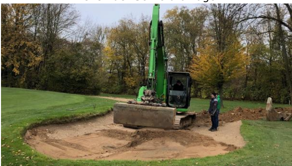
Arbeiten im Bunker Bahn 16
