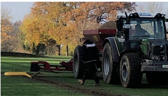
Ziehen der Schlitzdrainagen
